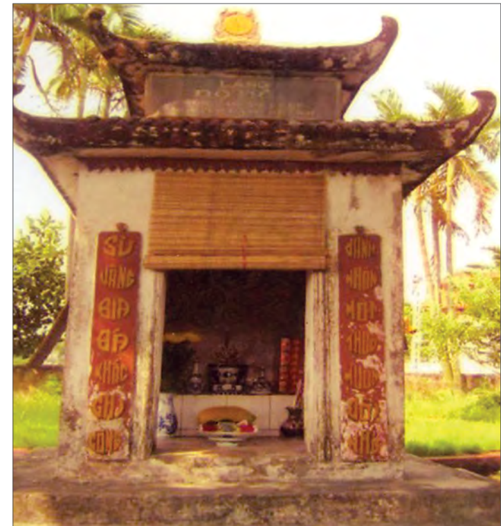
Am thờ lăng mộ Quận công Nguyễn Đăng Doanh, xã Yên Thường
